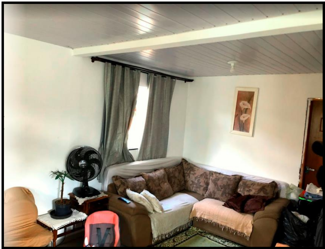
Ampliação da sala com remoção de parede.
