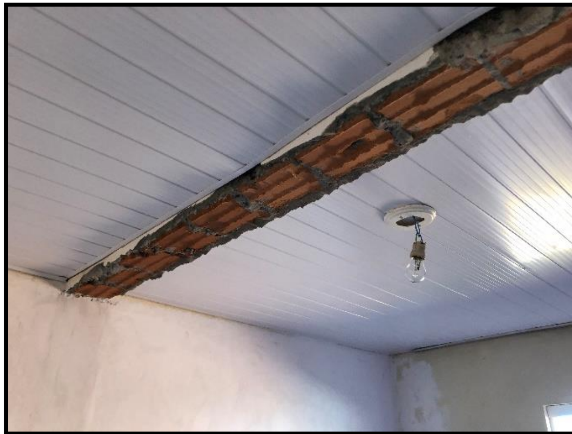
Remoção de parede de banheiro.
