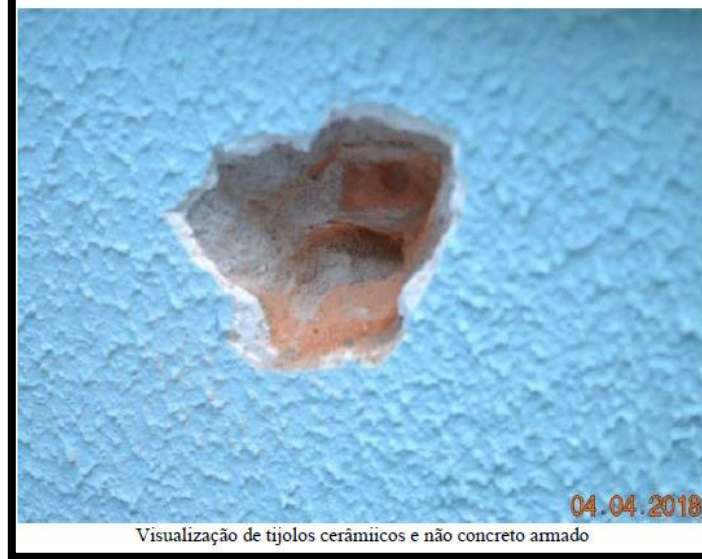
Uso de furadeira para identificar a ausência de pilares
