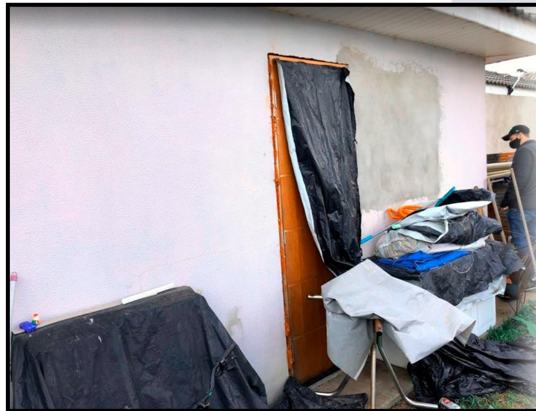
Retirada de janela original e execução de porta.
