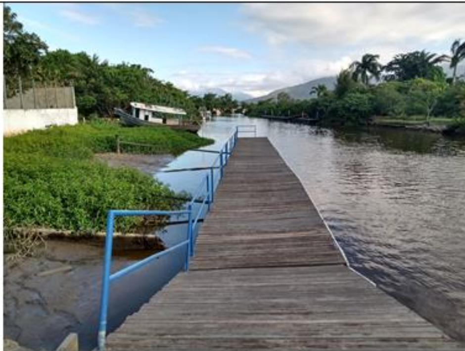
Cais visto do início, partindo da laje.
