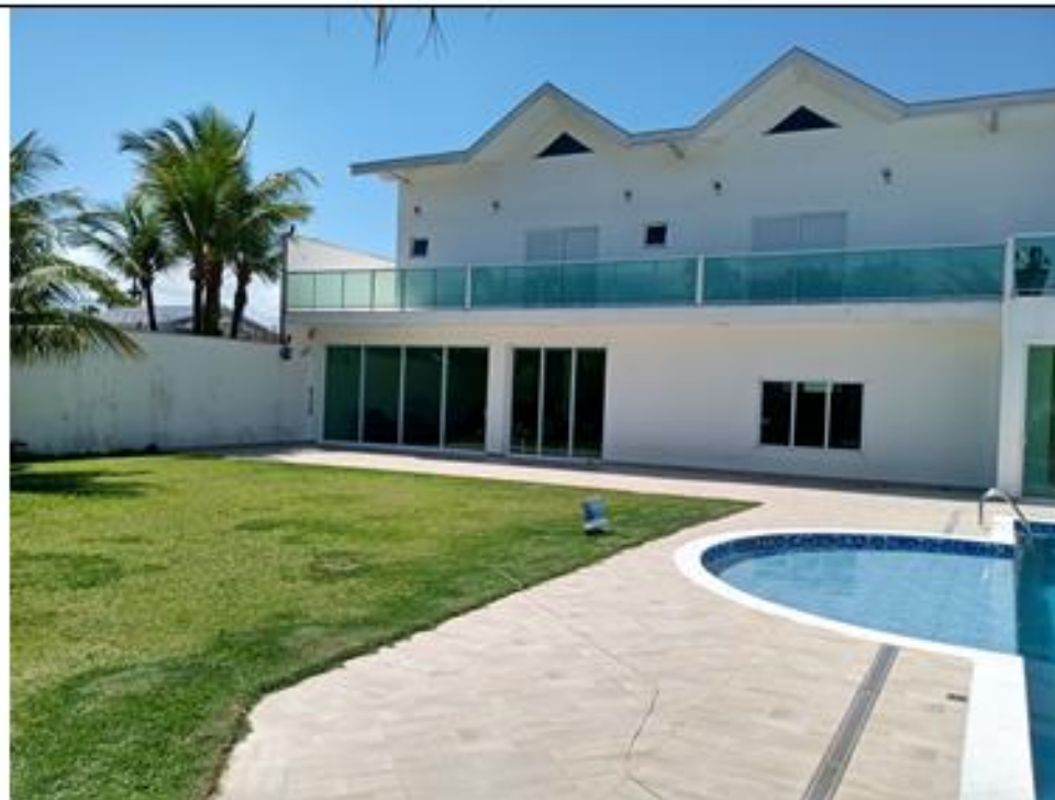
Parte esquerda, frontal da edificação residencial
