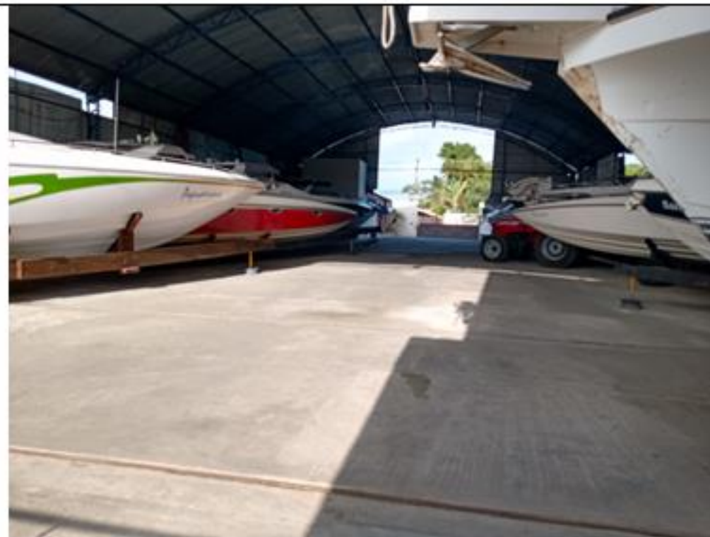
Foto do interior do galpão
