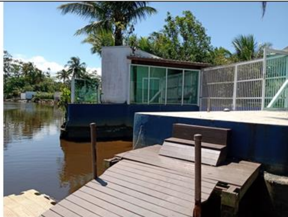
Detalhe da parte do píer em madeira
