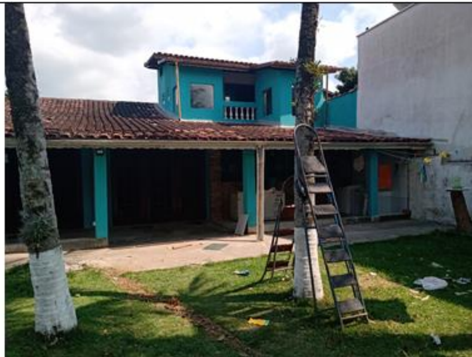
Foto da frente da edificação, mostrando o piso superior, na extrema direita do lote.
