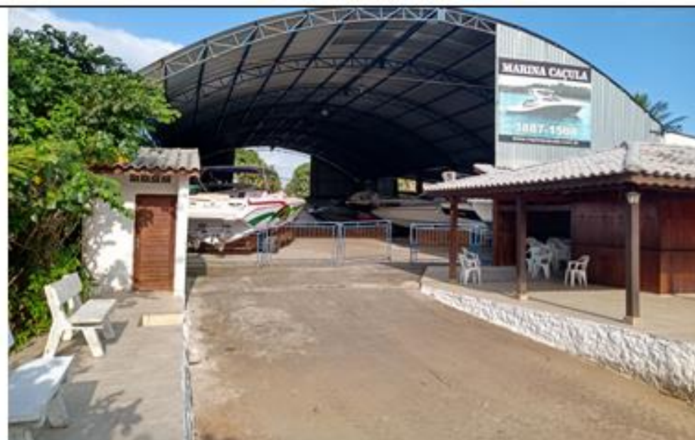
Rampa de embarcações vista da saída para o rio
