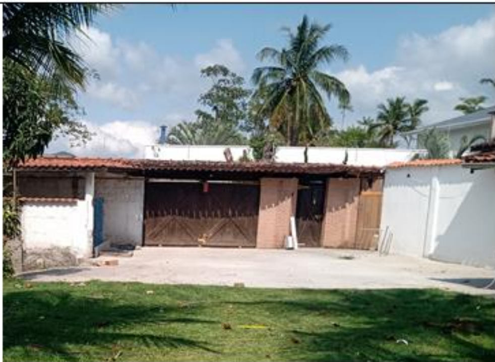
Calçada/estacionamento visto do interior do imóvel.
