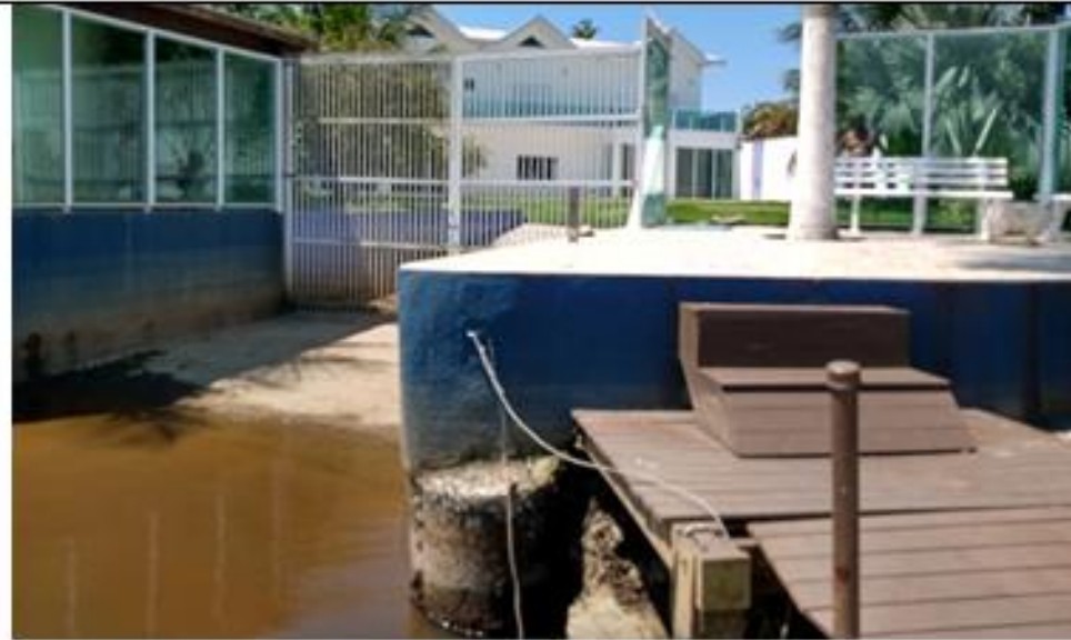
Rampa de embarcações vista da saída para o rio
