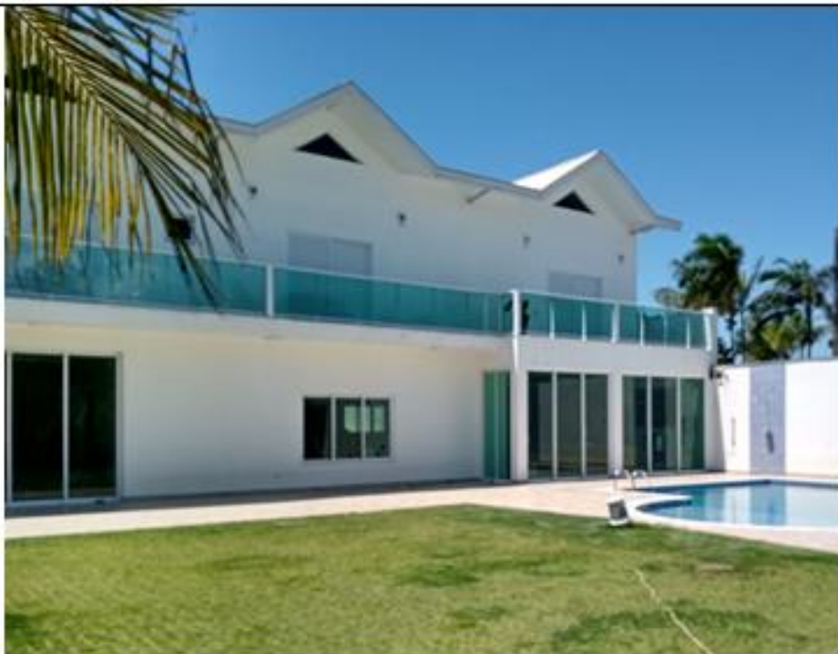
Parte direita, frontal da edificação residencial
