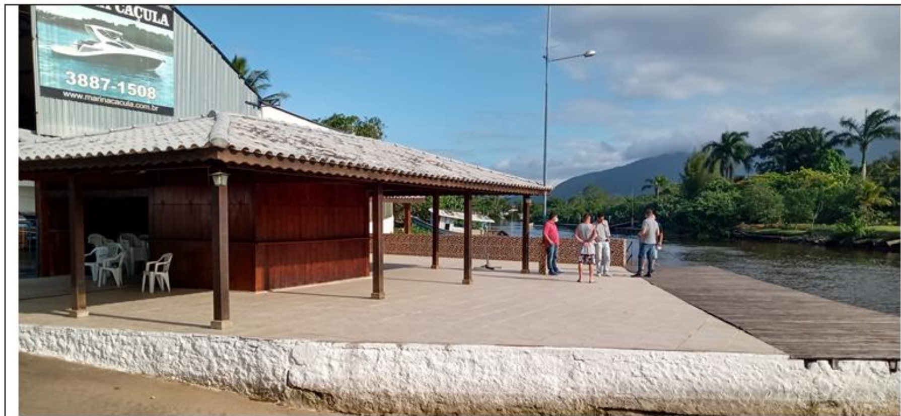
Laje de concreto vista da rampa
