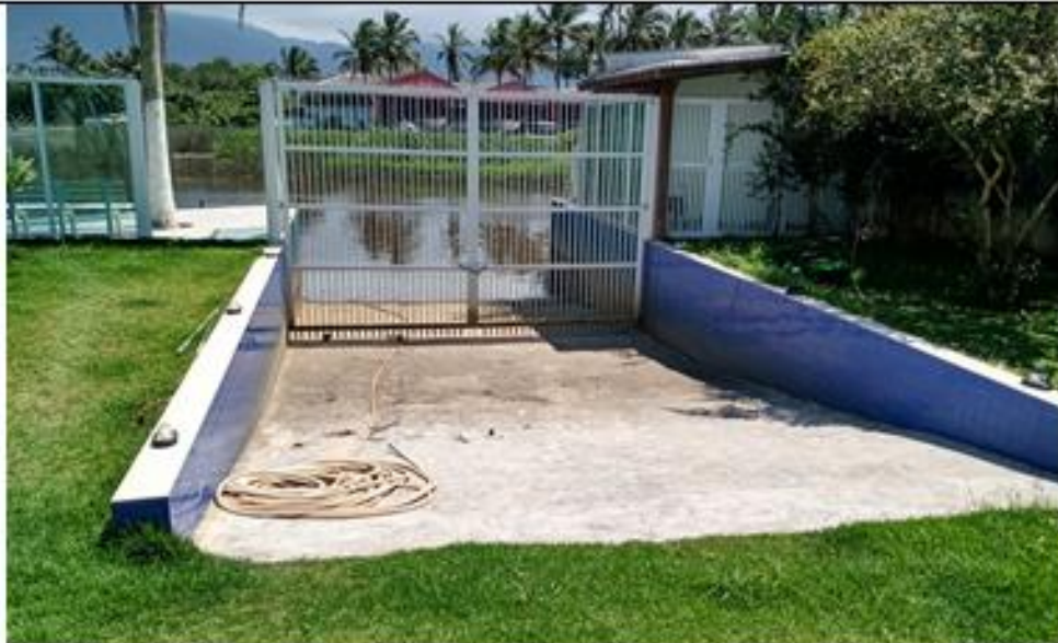
Rampa de embarcações vista do interior do imóvel
