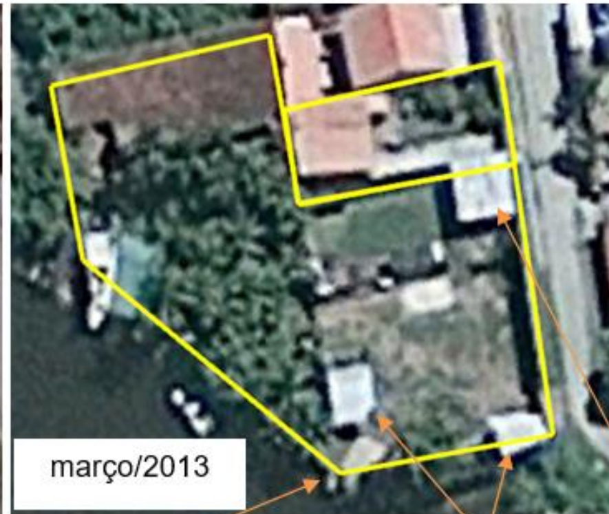
Rampa de embarcações
