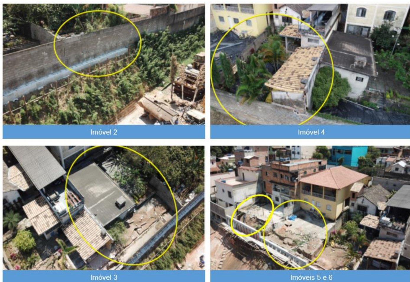
Figura 6 – Exemplos de áreas atingidas pelo deslizamento do talude
