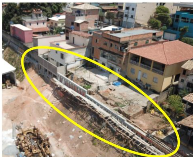
Muro de contenção que está sendo construído na divisa com a empresa A
