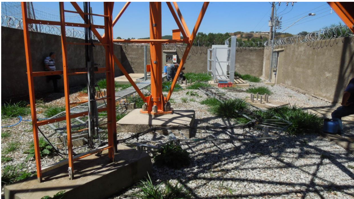
Imagem 01 – Torre de antena de celular já implantada e as suas bases de apoio. Fonte: Autores
