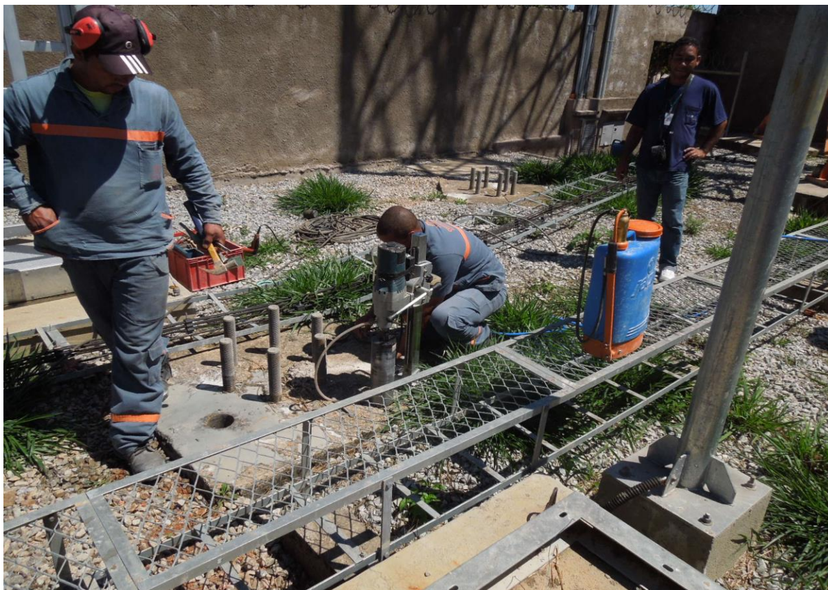
Imagem 03 – Preparação e extração de testemunhos do Bloco 01. Fonte: Autores
