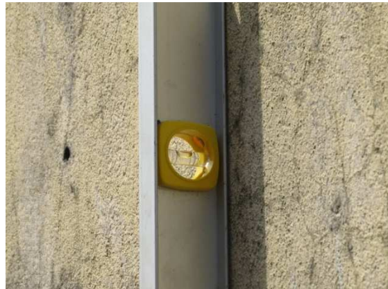
Figura 51 - PAREDE LATERAL DIREITA. Face interna. Detalhe da figura anterior
