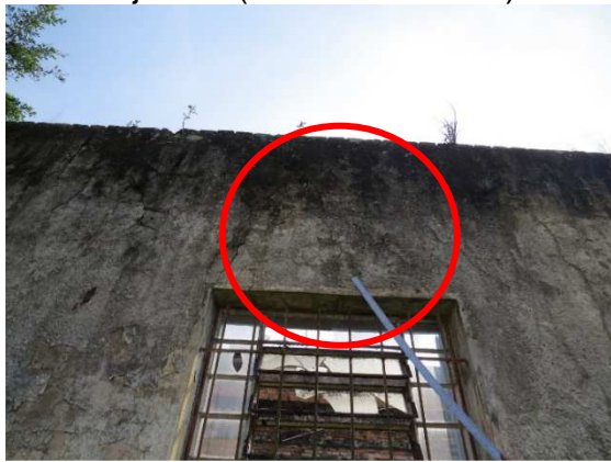
Figura 60 - PAREDE LATERAL DIREITA. Face externa. Ausência de vergas, nas janelas (círculo vermelho)
