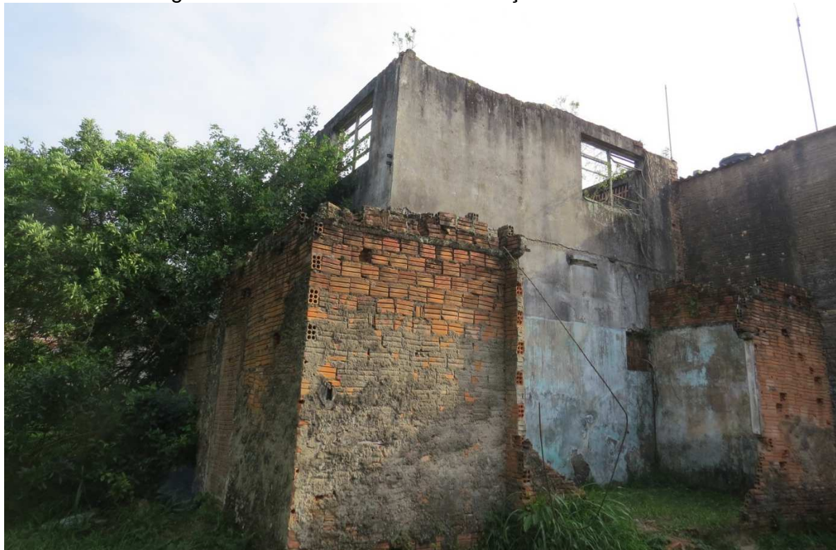
Figura 7 - Sala 2 / Fundos da edificação. Vista externa.
