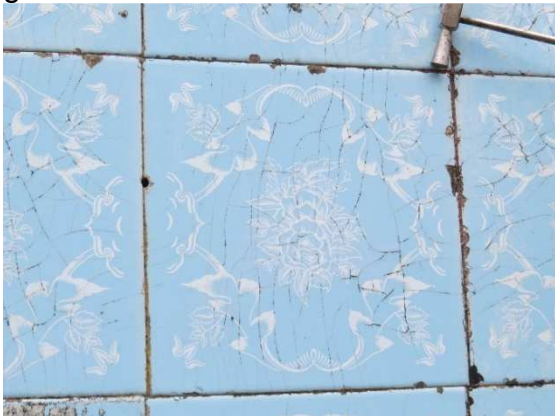
Figura 18 - FACHADA FRONTAL. Face externa. Azulejos com intenso gretamento
