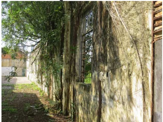
Figura 38 - Parede lateral direita. Face interna. Vista geral
