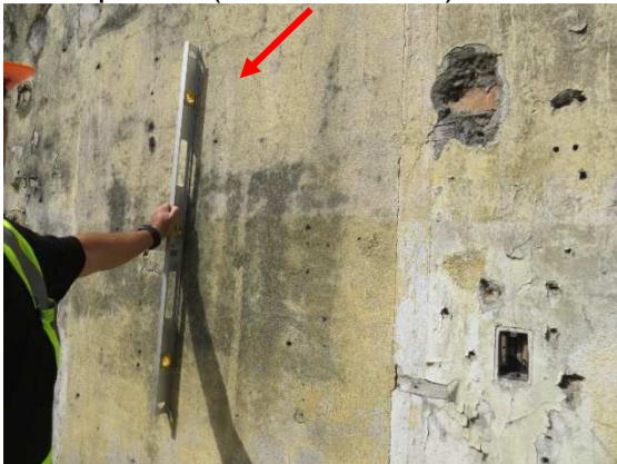
Figura 50 - PAREDE LATERAL DIREITA. Face interna. Verificação de nível/ prumo (seta vermelha)
