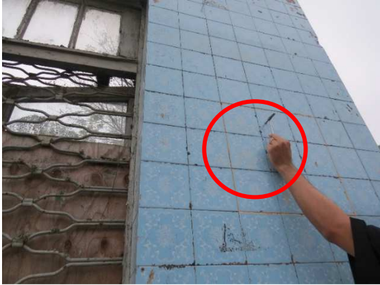
Figura 18 - FACHADA FRONTAL. Face externa. Azulejos com intenso gretamento
