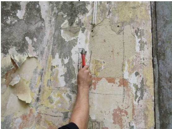
Figura 26 - FACHADA FRONTAL. Face interna. Teste de percussão
