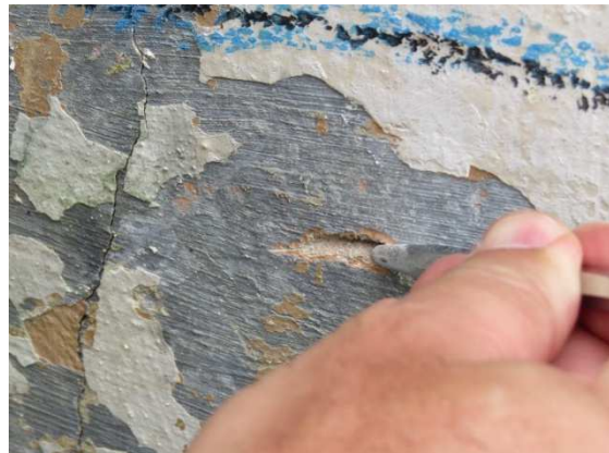
Figura 31 - PAREDE LATERAL ESQUERDA. Face interna. Teste de resistência ao risco
