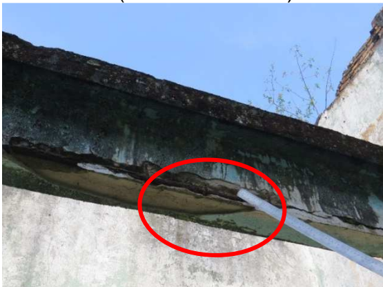
Figura 72 - SALA 2/ FUNDOS. Interno. Viga com corrosão intensa de armaduras (círculo vermelho)
