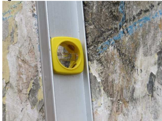
Figura 37 - PAREDE LATERAL ESQUERDA. Face interna. Detalhe da figura anterior
