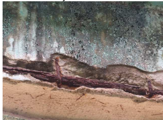
Figura 73 - SALA 2/ FUNDOS. Interno. Detalhe da figura anterior. Notar corrosão avançada
