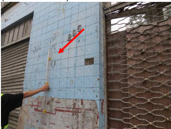
Figura 14 - FACHADA FRONTAL. Face externa. Verificação de nível/ prumo (seta vermelha)
