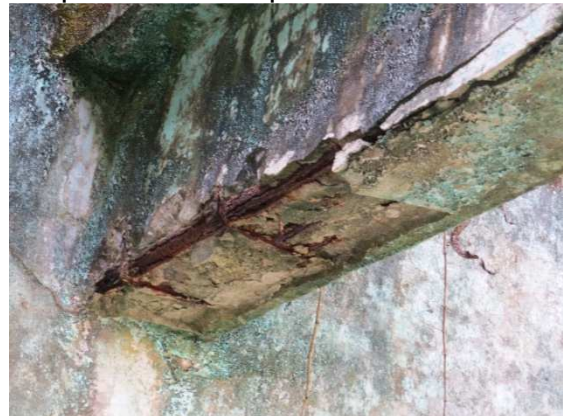
Figura 71 - SALA 2/ FUNDOS. Interno. Detalhe da figura anterior. Notar deslocamento espontâneo do concreto
