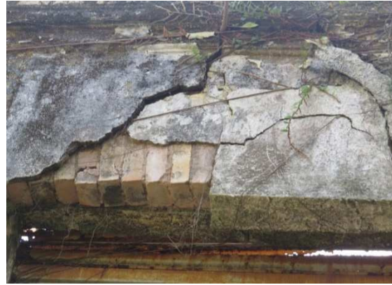
Figura 59 - PAREDE LATERAL DIREITA. Face externa. Detalhe da figura anterior
