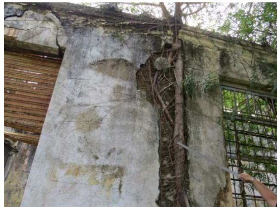
Figura 57 - PAREDE LATERAL DIREITA. Face externa. Detalhe da figura anterior. Notar o uso de tijolos encunhados, sobre o vão da porta
