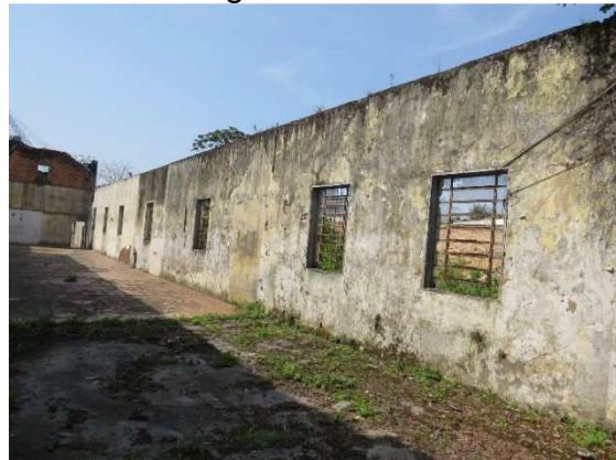
Figura 39 - Parede lateral direita. Face interna. Vista geral
