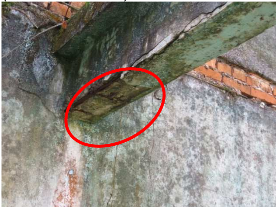
Figura 70 - SALA 2/ FUNDOS. Interno. Viga com corrosão intensa de armaduras (círculo vermelho)
