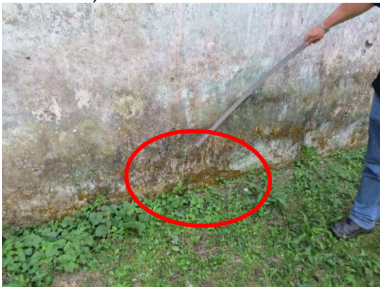
Figura 82 - SALA 2/ FUNDOS. Interno. Evidências de elevada umidade, presente na base das paredes (círculo vermelho)
