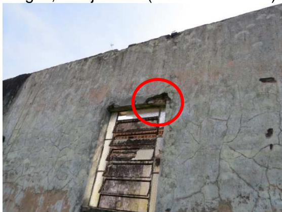
Figura 60 - PAREDE LATERAL DIREITA. Face externa. Ausência de vergas, nas janelas (círculo vermelho)
