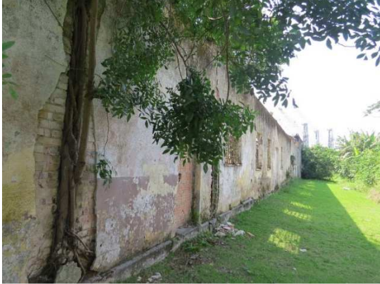
Figura 52 - PAREDE LATERAL DIREITA. Face externa. Vista geral
