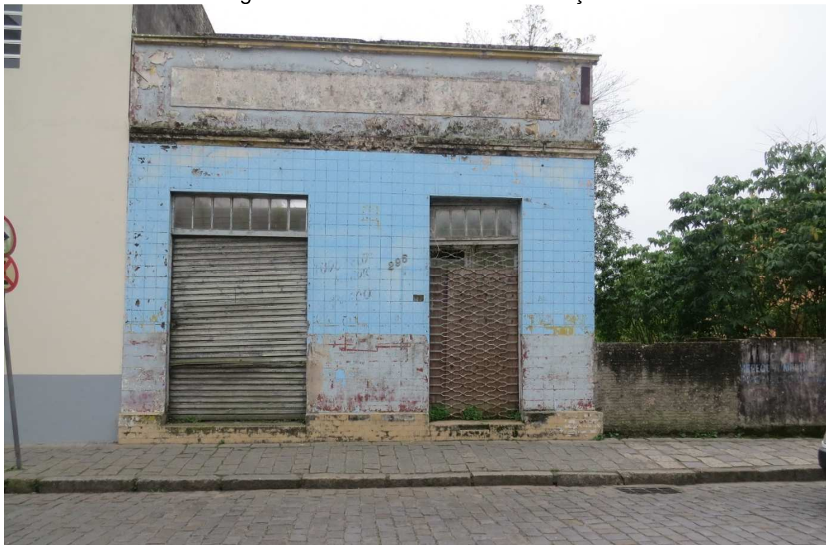
Figura 1 - Fachada frontal da edificação.
