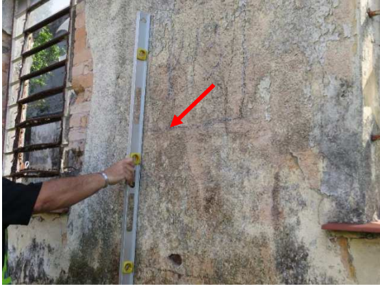
Figura 64 - PAREDE LATERAL DIREITA. Face externa. Verificação de nível/ prumo (seta vermelha)
