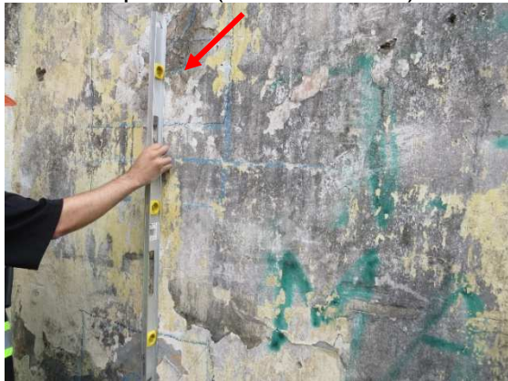
Figura 36 - PAREDE LATERAL ESQUERDA. Face interna. Verificação de nível/ prumo (seta vermelha)
