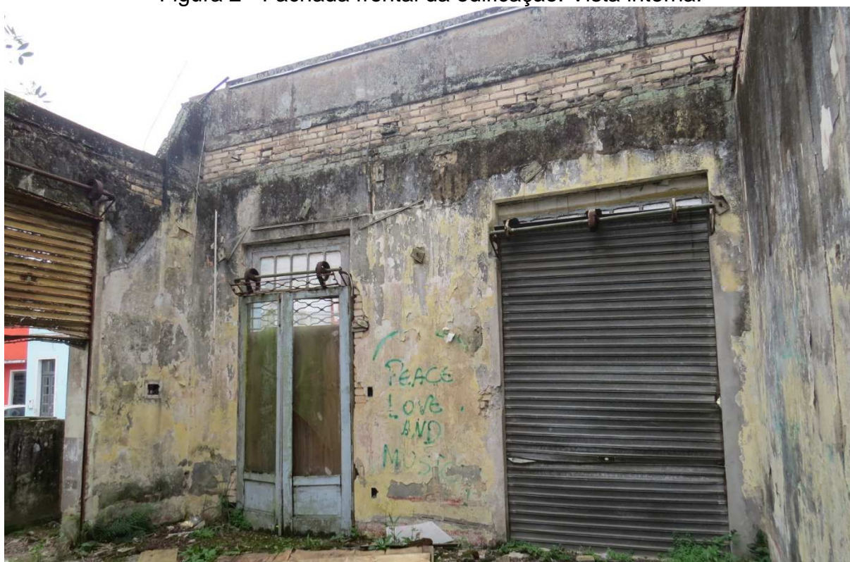
Figura 2 - Fachada frontal da edificação. Vista interna.
