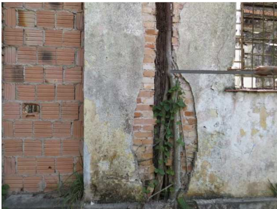
Figura 54 - PAREDE LATERAL DIREITA. Face externa. Notar crescimento de arbusto, entre a alvenaria, no local de um antigo pilar em madeira
