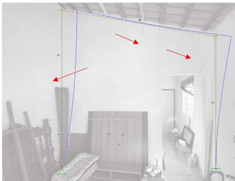
**Figura 13** – A imagem acima ilustra o deslocamento gerado pelo acréscimo do carregamento do aterro executado no lote 17. Fonte: Autor.
