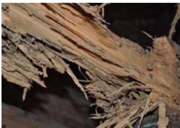
Figura 10 - seção de viga de madeira quase completamente deteriorada por ataques de térmitas (cupins). Fonte: Brito, 2014.
