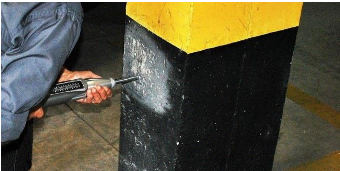
b) Esclerometria, aparelho que mede o resultado do impacto no concreto.
