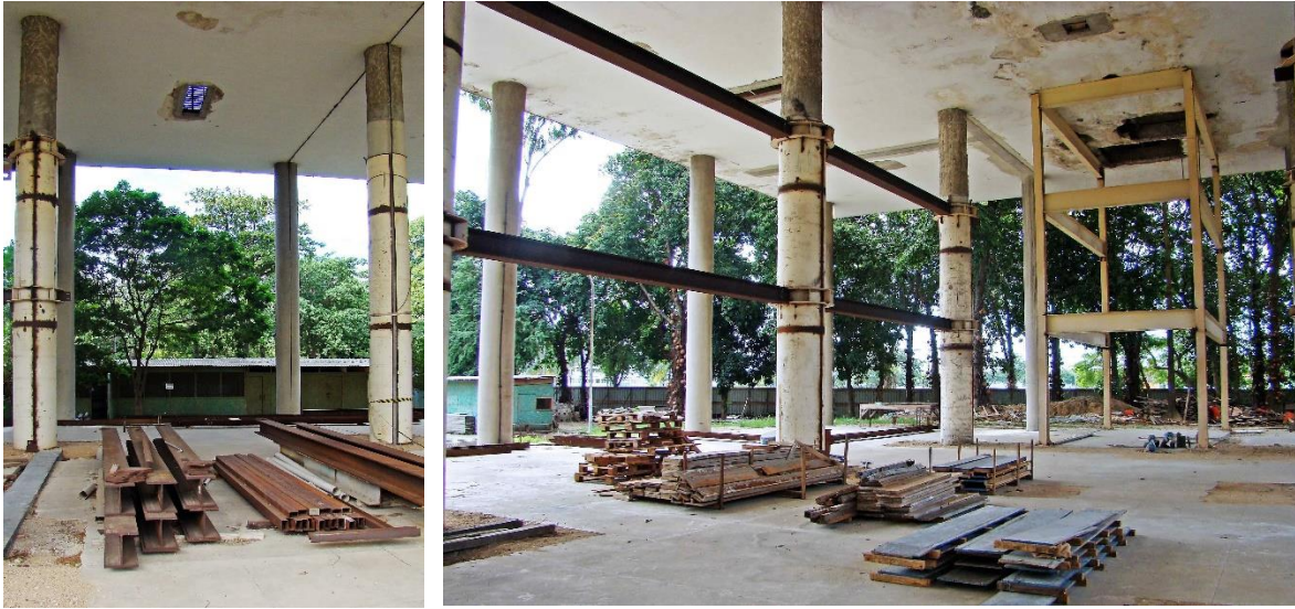
Escoramento feito com perfis de aço contra a flambagem de pilares corroídos.
