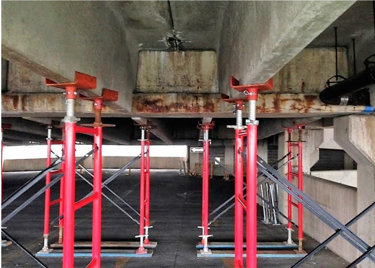
Escoramentos feitos com torres metálicas prontas. Também é material alugado no mercado que pode ser disponibilizado rapidamente para efetuar o procedimento.
