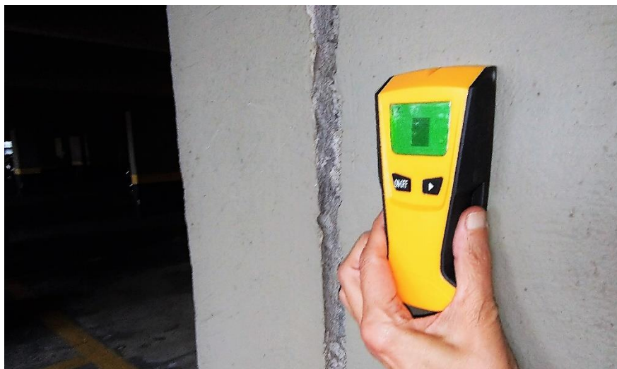
Verificando o espaçamento dos estribos na altura de um pilar
