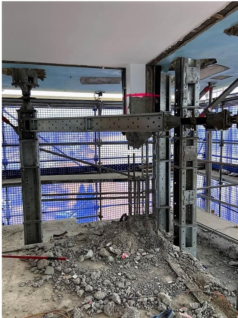
Escoramento especial devidamente calculado como estrutura de aço para atender a esta situação específica no trabalho de recomposição de um pilar colapsado.
