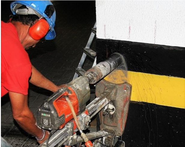
a) Extração de testemunhos com ruptura em laboratório.
