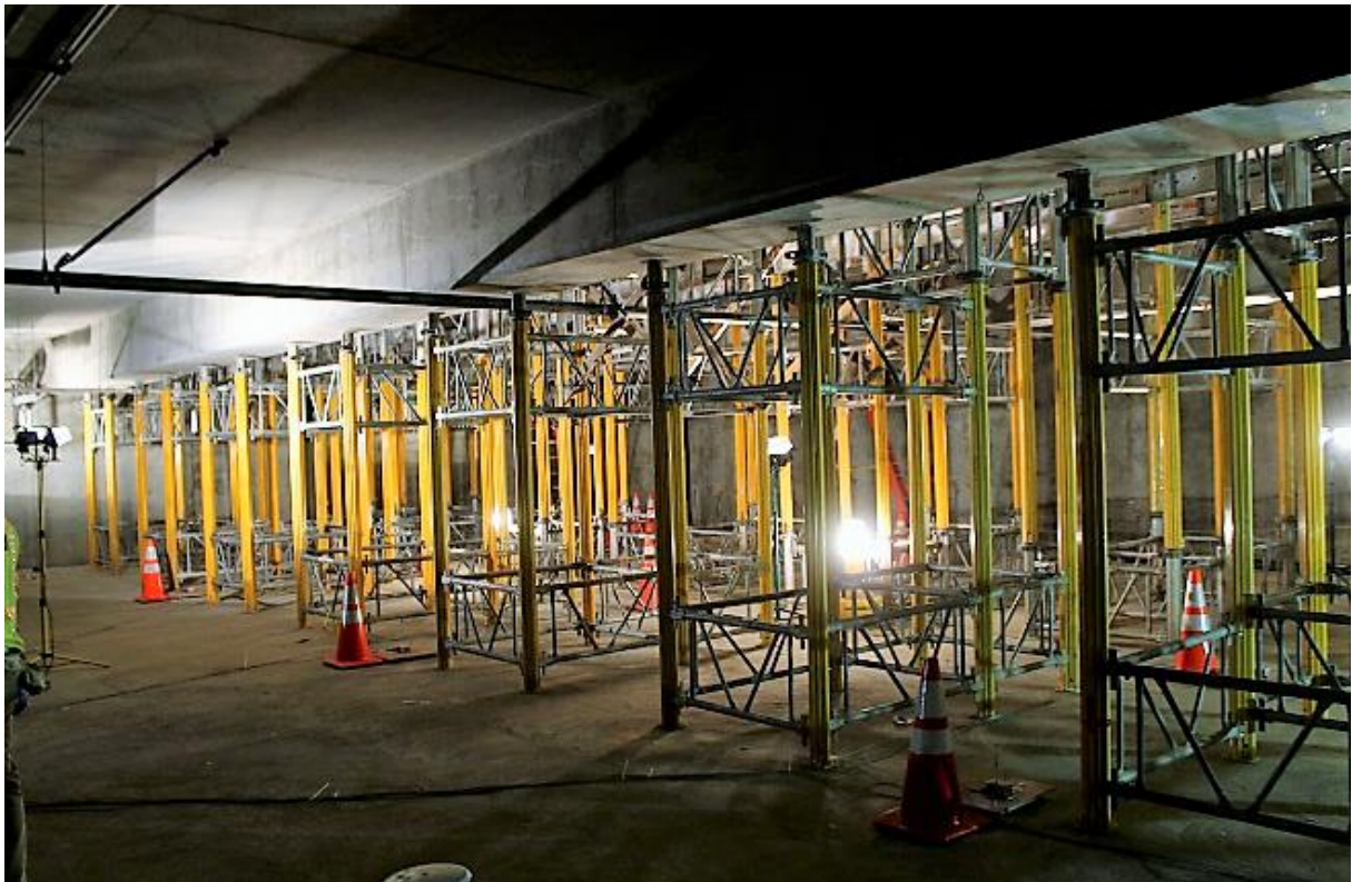
Escoramentos feitos com torres metálicas prontas. Também é material alugado no mercado que pode ser disponibilizado rapidamente para efetuar o procedimento.
