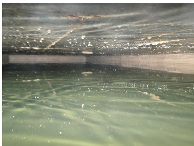
Figura 8 – Vista da superfície superior do reservatório sem impermeabilização (autoria própria)
