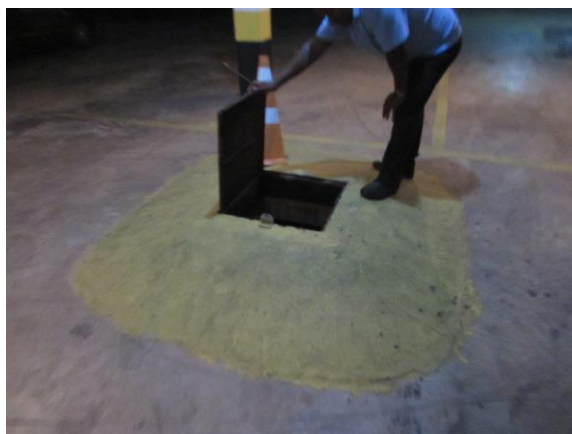
Figura 18 – Rebordo em torno da tampa do reservatório do estudo de caso B (autoria própria).
