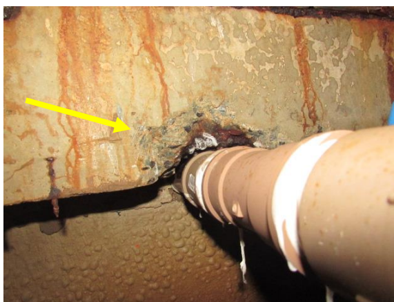
Figura 22 – Vista de escarificação do revestimento de viga do reservatório (autoria própria).
