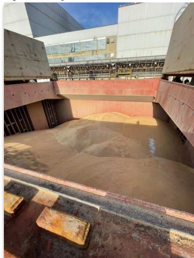
Foto 2: Área interna dos porões de carga.
