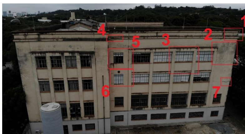
Figura 16 – Fachada noroeste-1 com destaque dos pontos de detalhamento.
