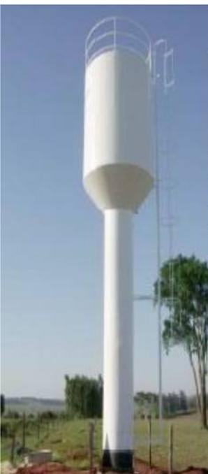
Caixa de água tipo taça **Coluna Seca**, são recomendadas para uso quando há a necessidade de maior pressão sobre a água, pois seu armazenamento é apenas na parte superior do reservatório, e a altura de sua coluna é o que define a intensidade da pressão exercida, pois quanto maior a altura da coluna, maior é a força da água durante a sua distribuição. Esse modelo em geral é utilizado em locais que possuam longa distância entre a caixa e o destino final da utilização da água.
